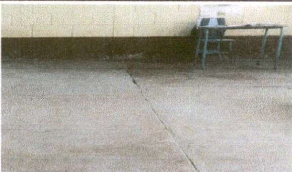
Foto 5: Sustrucción de piso ceramico Dirección y bodega
