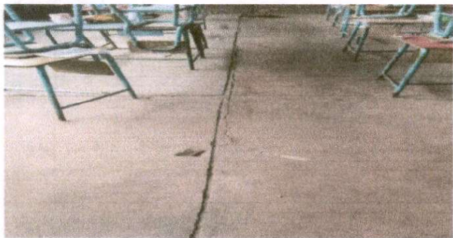
Foto1: Sustrucción de piso ceramico aula No. 1
